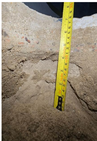
Ilustración 10. Espesores del contrapiso y el relleno.
