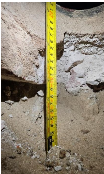
Ilustración 9. Espesores del contrapiso y el relleno.
